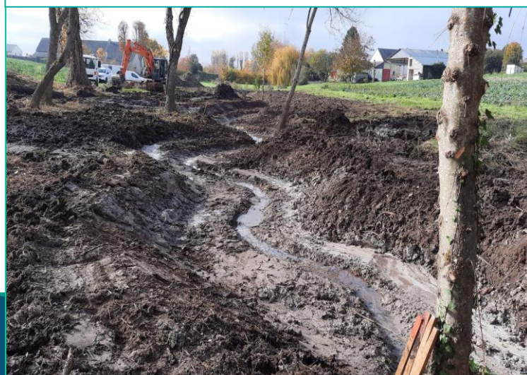
Jusqu'à-là rectiligne, le Comprigny a fait l'objet d'un reméandrage en 2021
